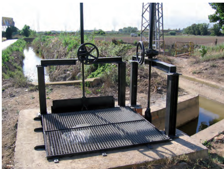
FIGURA 12. Comporta de derivació del canal principal. Autor: Xavi Pérez - Parc Agrari del Baix Llobregat.
