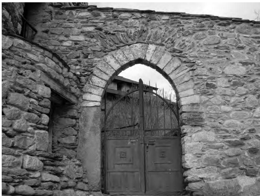
FIGURA 26. L'accés al recinte de l'església de Son és obrat amb diversos tipus de roques; el pilar de l'esquerra és d'una sola peça de granitoide ben tallat, mentre que el de la dreta és fet de carreus d'aquesta mateixa roca. L'arc és fet de dovelles de marbre i al damunt hi ha restes d'obra en forma de llibre feta amb caires de gresos i pissarres cambroordovicians. A la resta del mur de tanca predominen els caires de granitoides.
