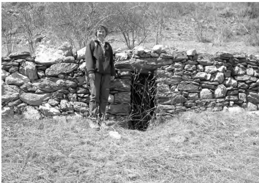
FIGURA 24. Entrada d'una «cabana de tros», prop d'Arrose. El mur del bancal, obrat amb pedra seca, evita l'erosió i rebaixa el pendent de les feixes. La cabana, perfectament integrada a l'obra, proporcionava aixopluc als qui treballaven en aquests trossos.
