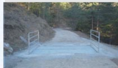
Instal·lació de passos canadencs
